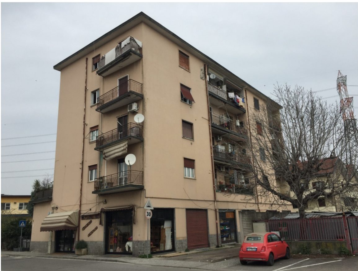
Foto 02 - Il fabbricato su via Primo Maggio
