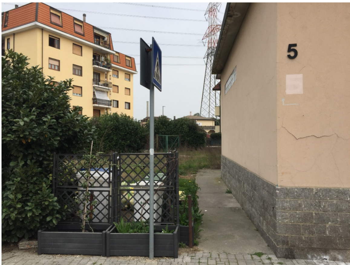
Foto 05 - Accesso al fabbricato dal civico 5 di via Primo Maggio
