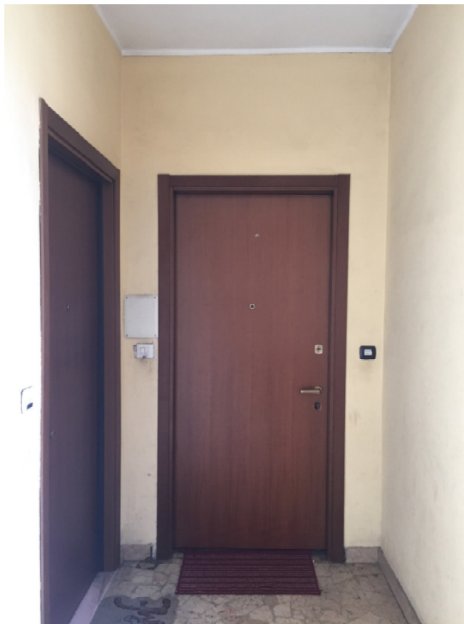
Foto 07 - Ingresso all'unità dal pianerottolo
