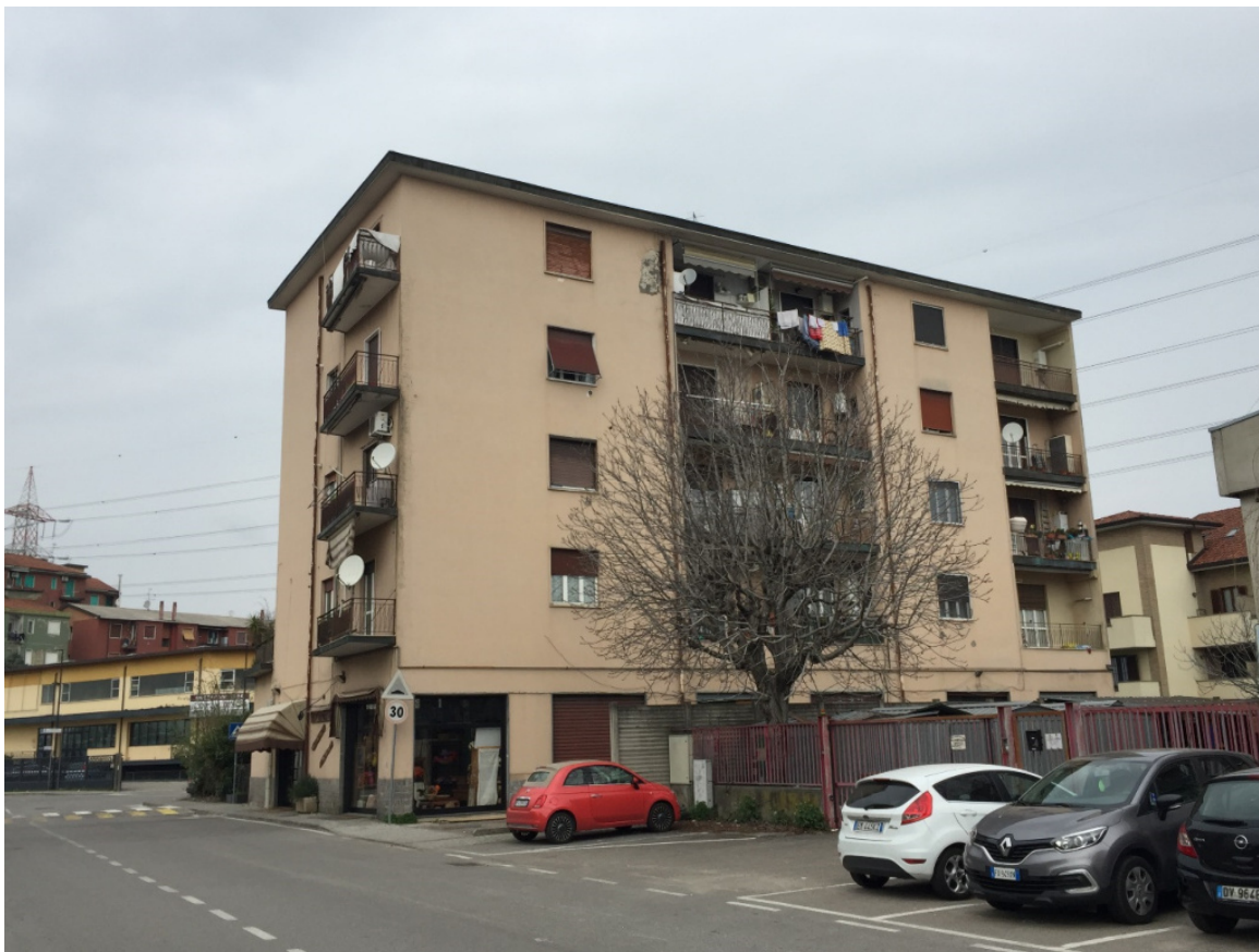
Foto 01 - Il fabbricato su via Primo Maggio
