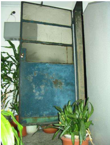
Foto 6: porta di ingresso al solaio
