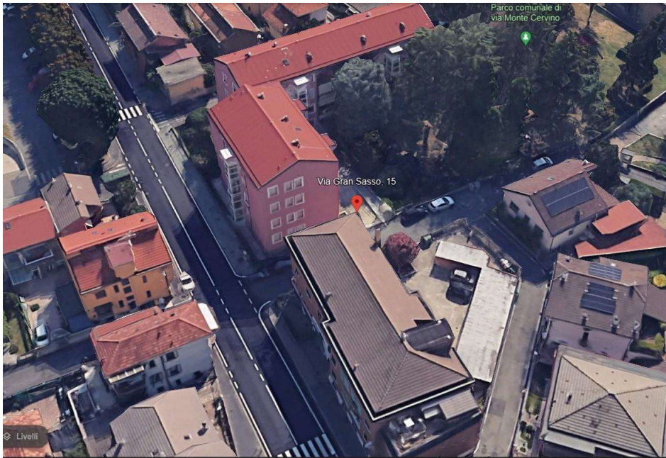
Foto 3 Vista della copertura e delle coperture confinanti
