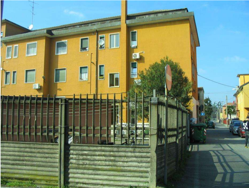
Foto 1: Edificio vista da Via Gran Sasso
