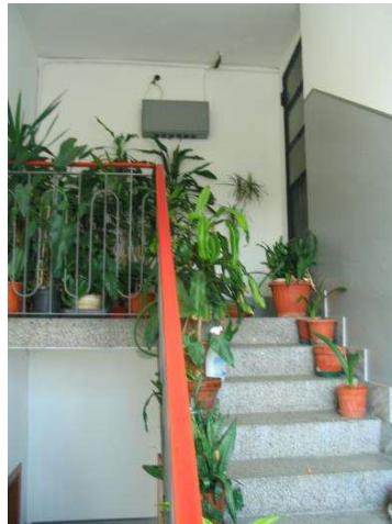
Foto 5: scala do accesso al solaio
