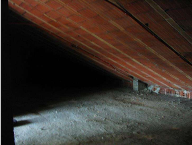
Foto 10: Pavimento in battuto di cemento grezzo
