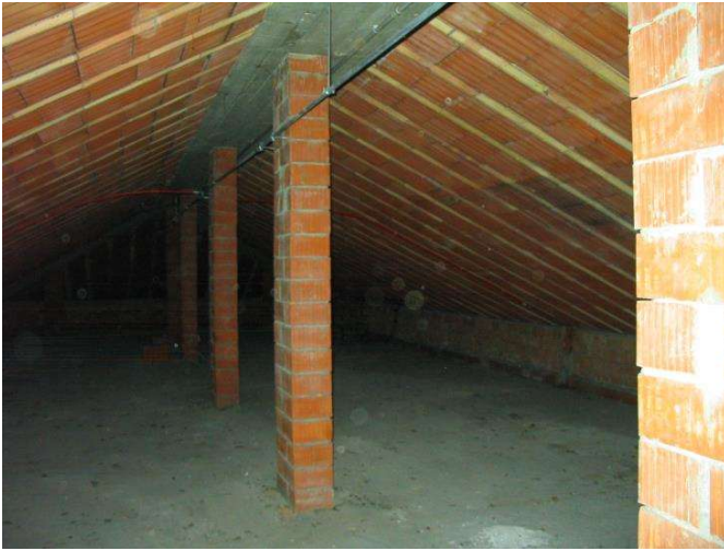
Foto 7: Solaio /Deposito dall'Ingresso
