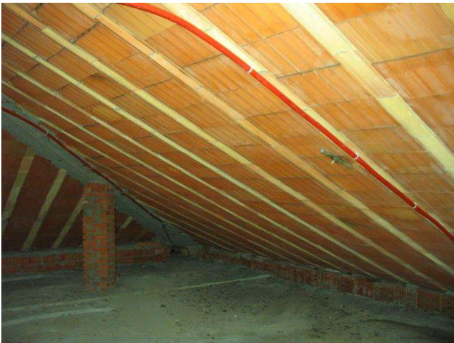
Foto 9: Solaio/Deposito dal fondo verso via Stelvio
